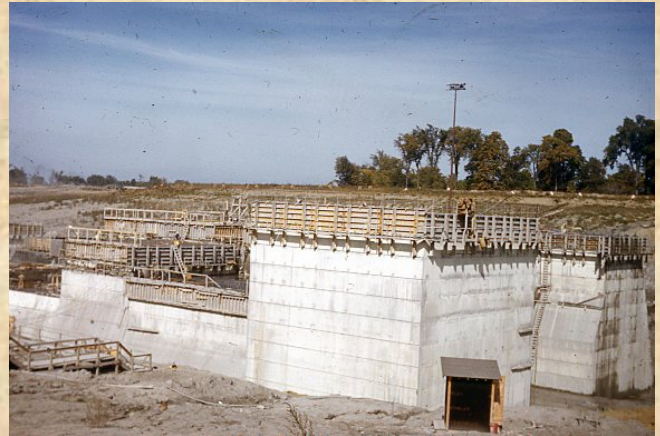
Layer pour of Lock in four foot stages.
